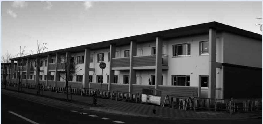
完成間近の表町団地3号棟
