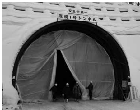
厚幌1号トンネルの外観
