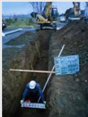
▶新町地区の水道敷設替工事
