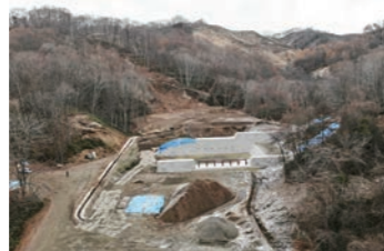
ウクル川右支川の砂防工事
