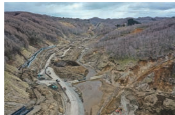
日高幌内川災害の復旧工事
