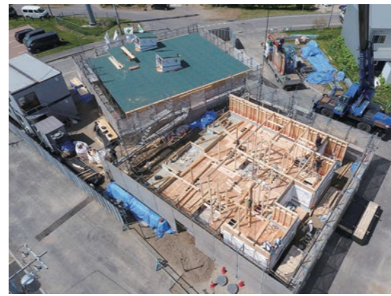
建設中の上厚真災害公営住宅
