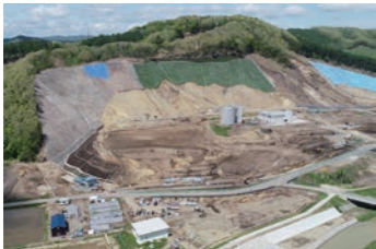
富里地区の斜面工事
