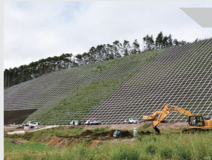
災害関連緊急治山事業が進む吉野地区
