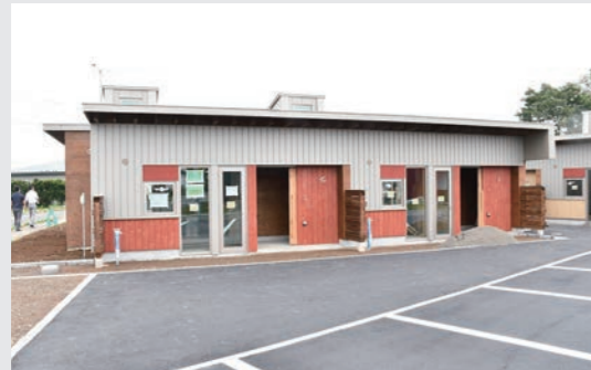
完成間近の上厚真あかり団地 上：床暖房が完備された室内 下：明るい木調の外観
