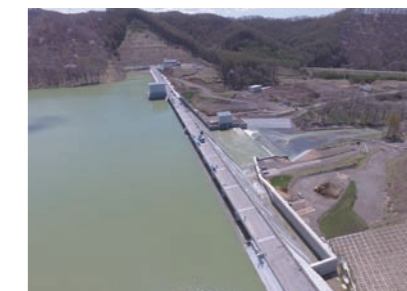
厚幌ダム建設事務所提供
