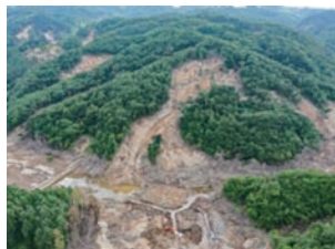
日高幌内川災害復旧工事（土砂ダム湖内
