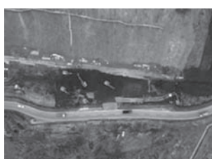
堆積した土砂の撤去工事（吉野地区）
