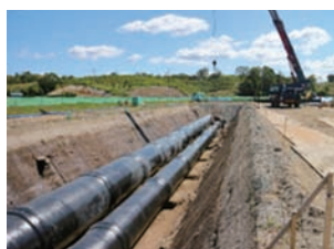
厚幌導水路の用水工事
