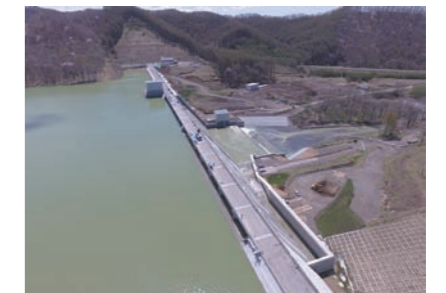
厚幌ダム建設事務所提供
