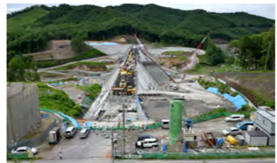
建設中の厚幌ダム
