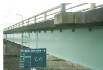
補修した橋梁
