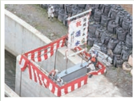
2日 厚幌ダム建設事業 本体工事湛水式
