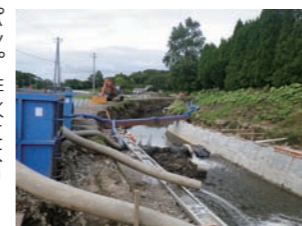
ポンプ排水により護岸ブロックを施工
