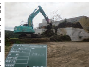
富里浄水場の周りに堆積した土砂の撤去
