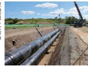
厚幌導水路の用水工事
