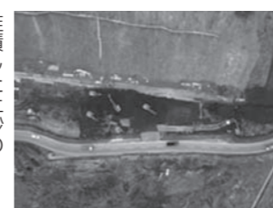
堆積した土砂の撤去工事(吉野地区)
