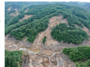
日高幌内川災害復旧工事(土砂ダム湖内の状況)
