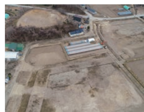
施工中(令和元年12月)
