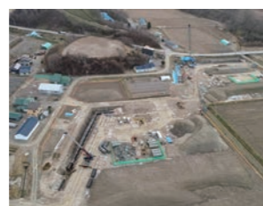
復旧工事完了(令和2年3月)
