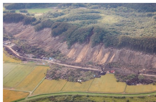
集落一帯が土砂に飲み込まれた吉野地区 (写真：国土交通省提供)
