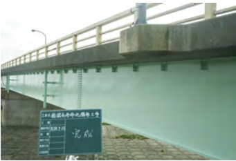
補修した橋梁
