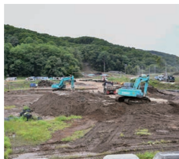
日高幌内川の災害復旧工事
