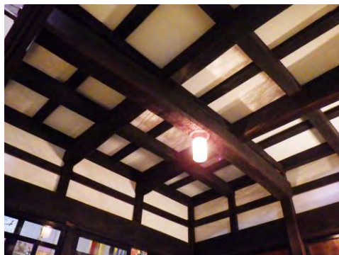
杵の内の梁組み（ハリマモン） 牛梁を中心にカタカナの「キ」印状に組み上げられる特徴があります。
