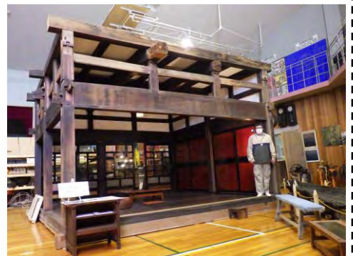
完成・展示公開している杵の内（旧木澤邸） 幅5m×奥行き4.7m×高さ4m、約14畳の広さで、釘は1本も使われていません。
