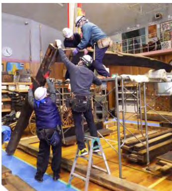
大工さんたちによる 牛梁の組み上げの様子
