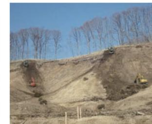
※のり枠工事：斜面上に格子状のモルタル・コンクリートを造成して斜面の安定化を図ります。
