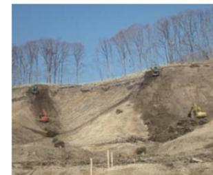
※のり枠工事：斜面上に格子状のモルタル・コンクリートを作成して斜面の安定化を図ります。
