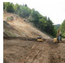
林道復旧工事 (幌内地区)
