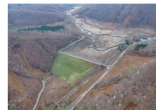
厚真ダム復旧工事 (幌内地区)
