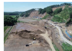
水田の土砂撤去および仕上げ状況 (高丘地区)
