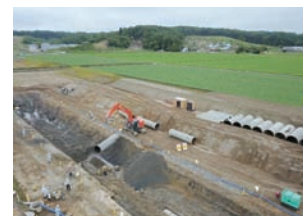
厚幌導水路復旧工事 (美里地区)
