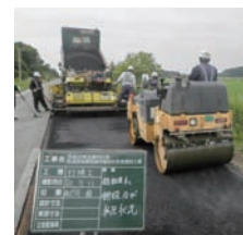
厚南開拓線復旧工事 (鯉沼地区)
