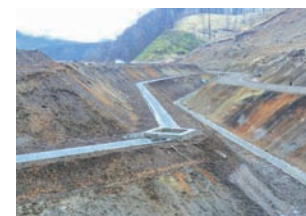
農業用水路および排水路の完成状況 (富里地区)
