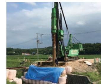
橋の下部工を施工するための鋼管くいを打設する重機
