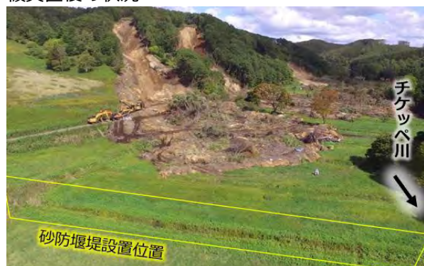
被災直後の状況
