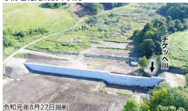
砂防堰堤完成後の状況
