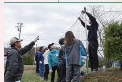
農家やボランティアなど延べ460人が協力し鹿侵入防止柵を再設置
