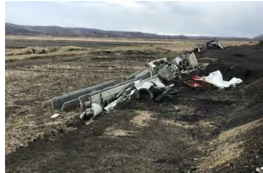
農業用水路の被害
