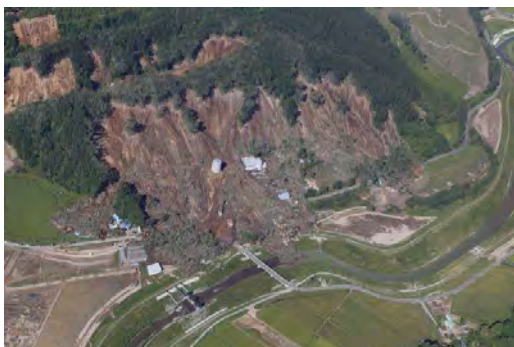
上幌内早来停車場線の閉塞（富里浄水場付近） （国土交通省提供）
