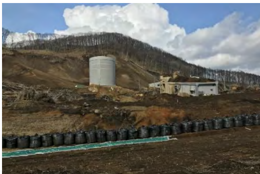
富里浄水場の被害
