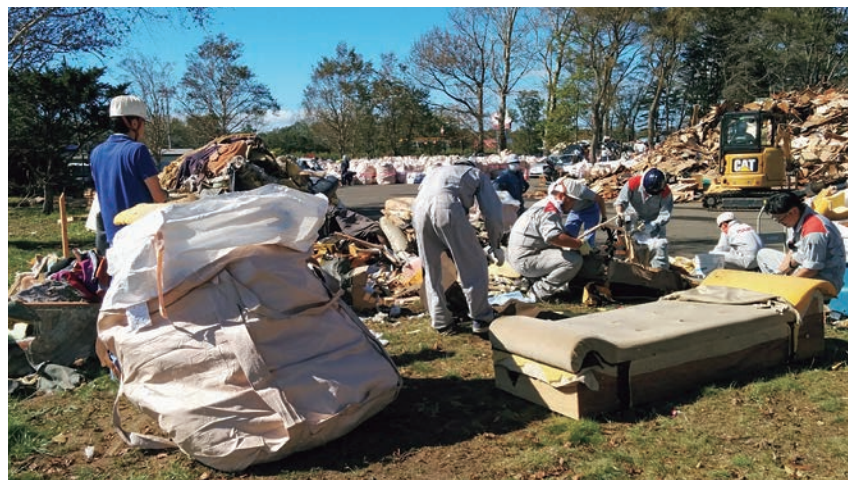
次々と運び込まれてくる災害ごみを分解、解体
