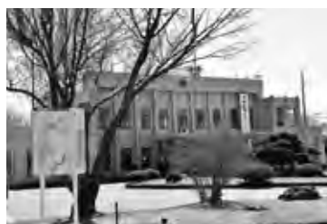
昭和28年に建築された役場庁舎
