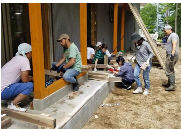
放課後子どもセンターのウッドデッキ作り
