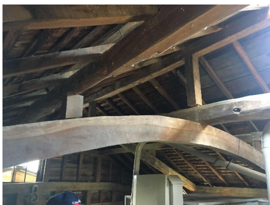
2 階梁組（解体前）
