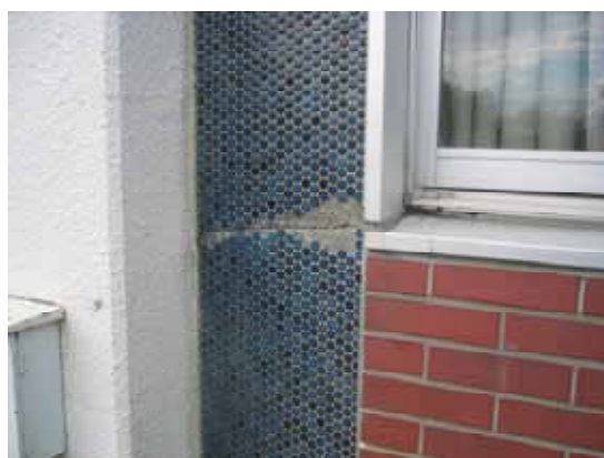
A 会館の袖壁の損傷
