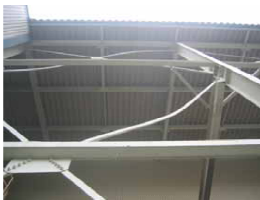
B 倉庫の筋交いの座屈
