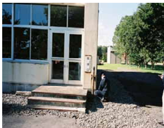
C 中学校の建物の沈下
