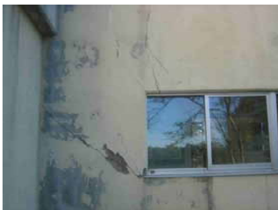
C 中学校の壁のひび割れ
