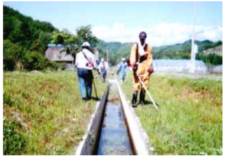
農業用水路の草刈り作業
