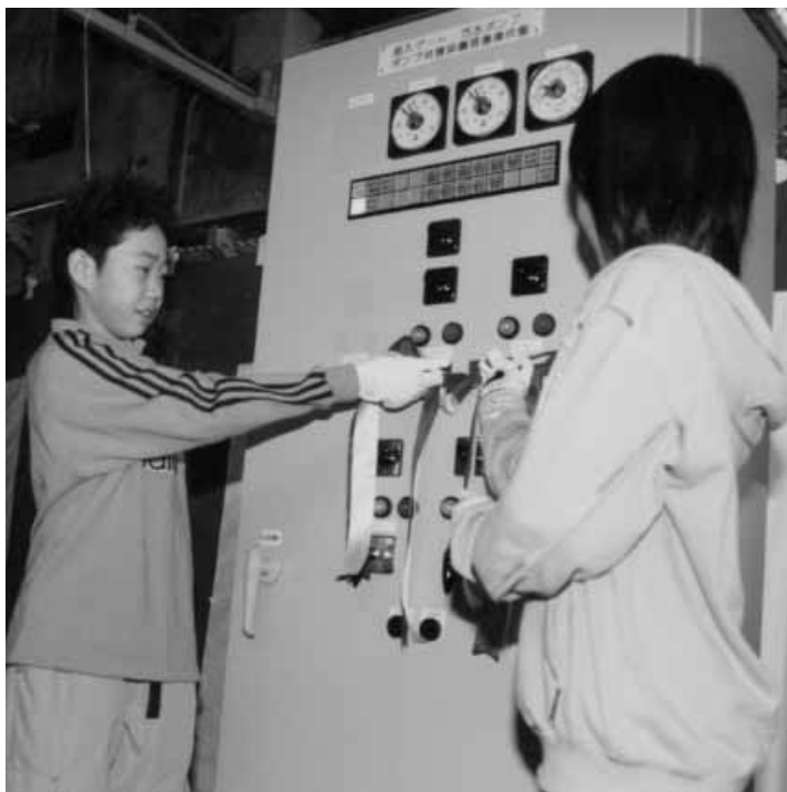
汚水ポンプのスイッチを入れ、稼動させる小学生
