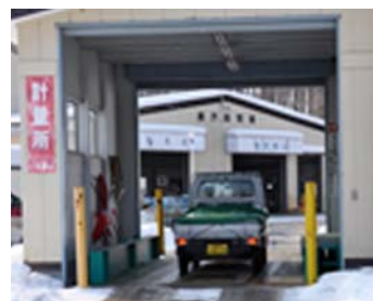
安平町、厚真町から出されるごみは、この計量棟で計量され、それぞれの貯留ピットへ向かう
