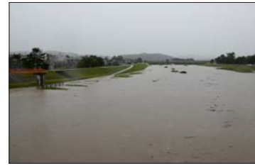
台風第9号により増水した厚真川（8月23日撮影）
