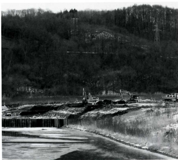
建設中の美里頭首工
