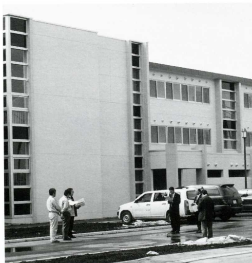
特定公共賃貸住宅のない表町公営住宅(1号棟)
