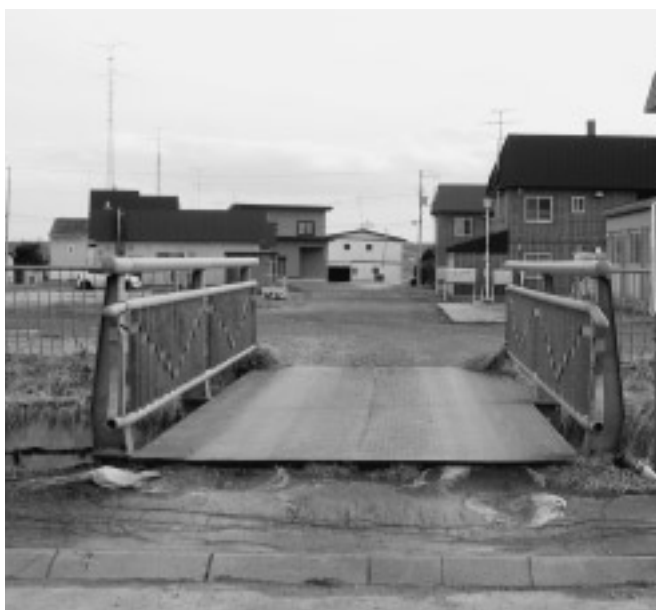
本郷団地内の人道橋
