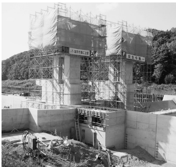
着々と進む国営事業（美里頭首工建設工事）
