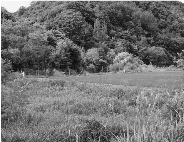
効果が現れている金網フェンスの設置
