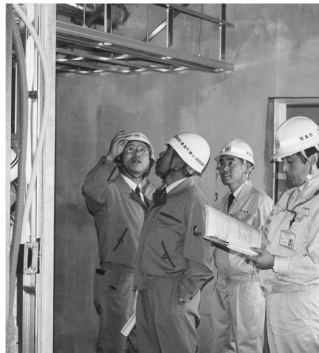
3号棟建設状況の現地調査
