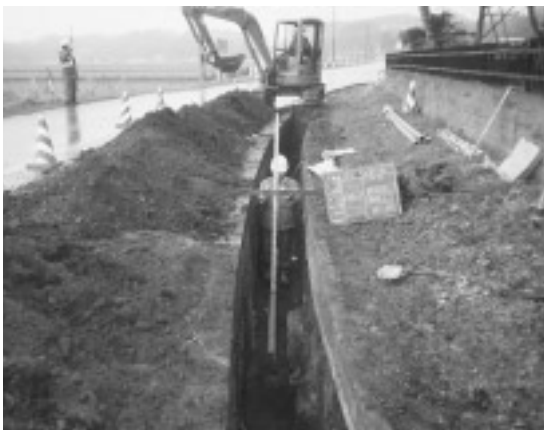
桜丘地区配水管布設工事
