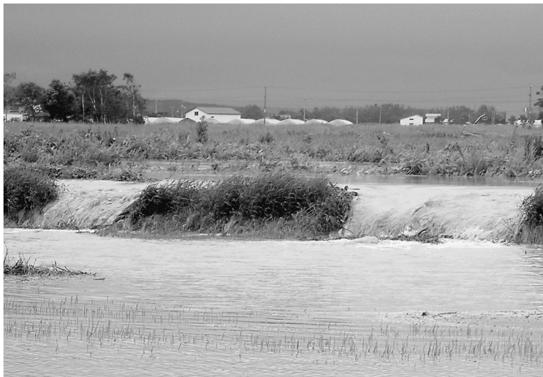
8月の大雨により、築堤の越流があった入鹿別川
