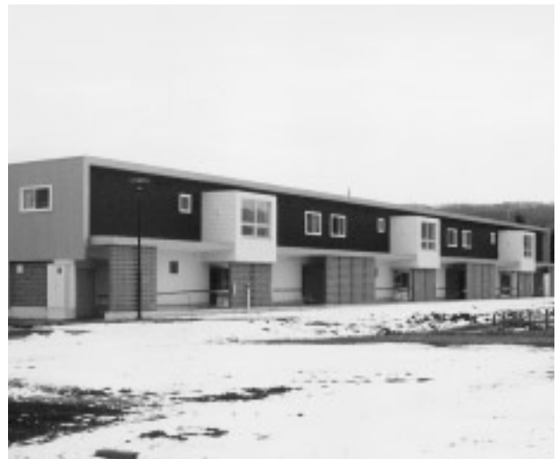
完成した本郷第2団地公営住宅1号棟
