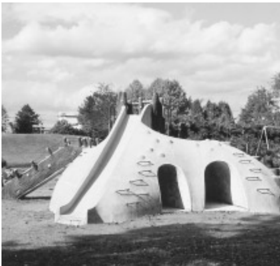
やっと補修された京町公園の滑り台
