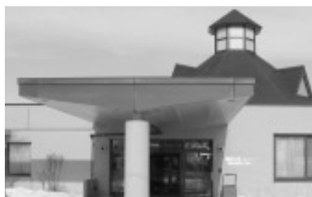
厚南デイサービスセンター外観
