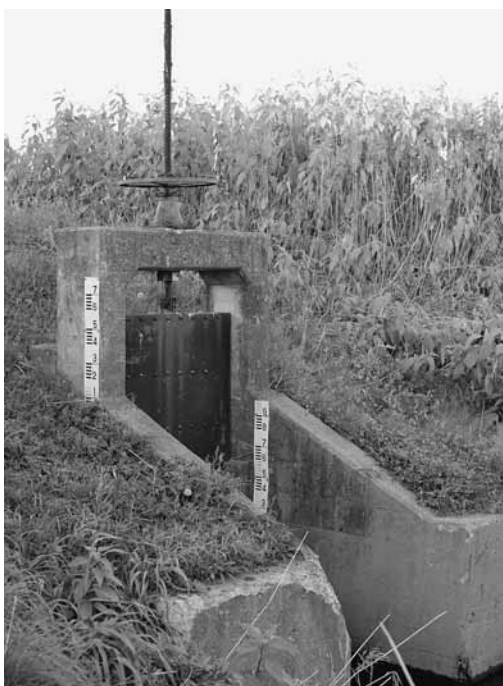
鹿沼地区の旧式樋門
