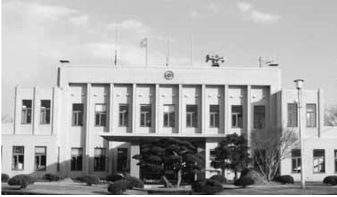
耐震強度に問題がある現庁舎
