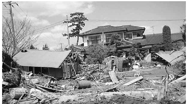
山元町の被災敷地
