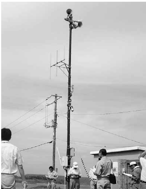
緊急通報に重要な役目を果たした 監視カメラ付き拡声器
