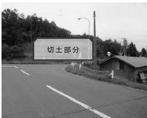
町道豊沢共栄線側から切土箇所を確認、 切土手前は道道千歳鷓川線
