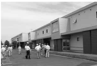
かえで団地6号棟(上厚真)の完成確認をした
