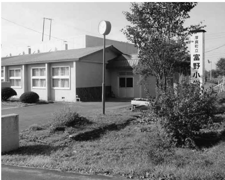
放課後子どもプランに活用する予定の富野小学校跡地
