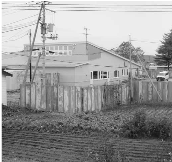
工事が進む京町保育園
