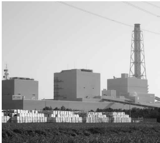
苫東厚真発電所の固定資産税ばかりに頼るわけにはいかない (苫東厚真発電所の写真)
