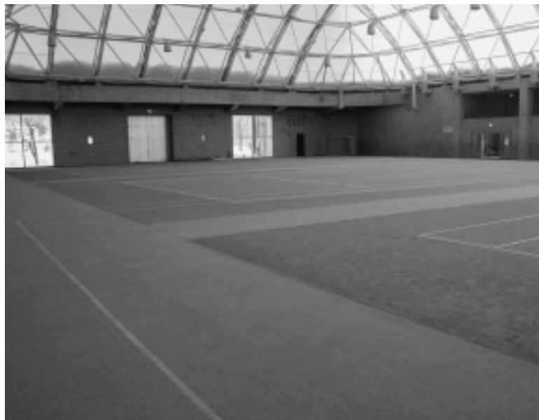
粉じん対策がされたスタードーム
