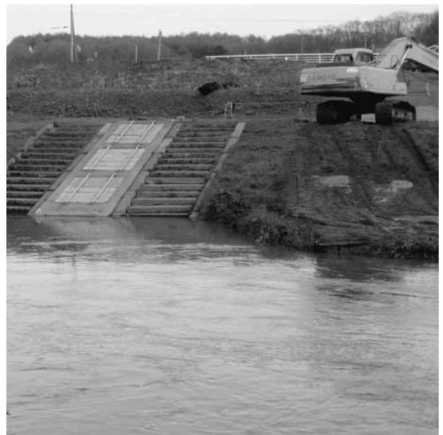
厚真川にある簡易水道の取水口
