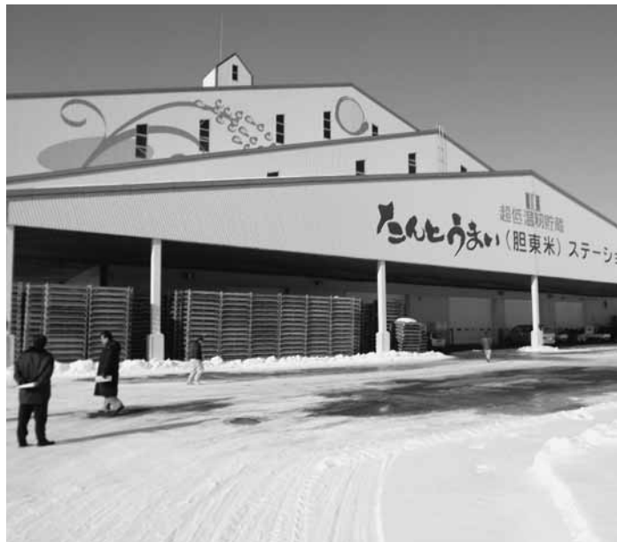
保管スペースが不足している、たんとう米ステーション
