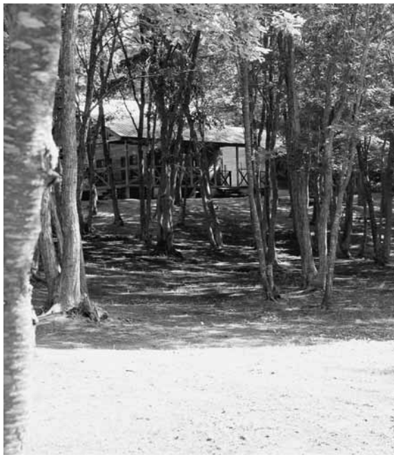
大沼野営場管理棟
